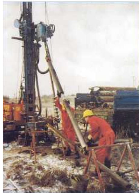
BPE Aufnehmen und Ablegen des Bodenproben- Entnahmegerätes von/auf Vorrichtung vor/nach Probennahme
